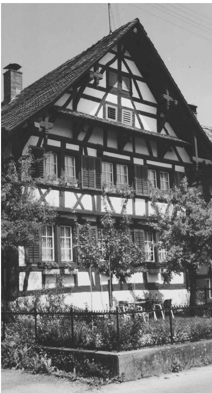
Eines der prachtvollen Marthaler Riegelhäuser.
