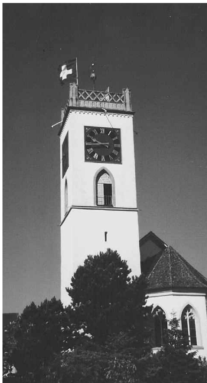
Der Kirchturm der reformierten Kirche Neftenbach, der einst eine Käsbisse trug, hat heute einen Abschluss mit Galerie und flacher Pyramide.
