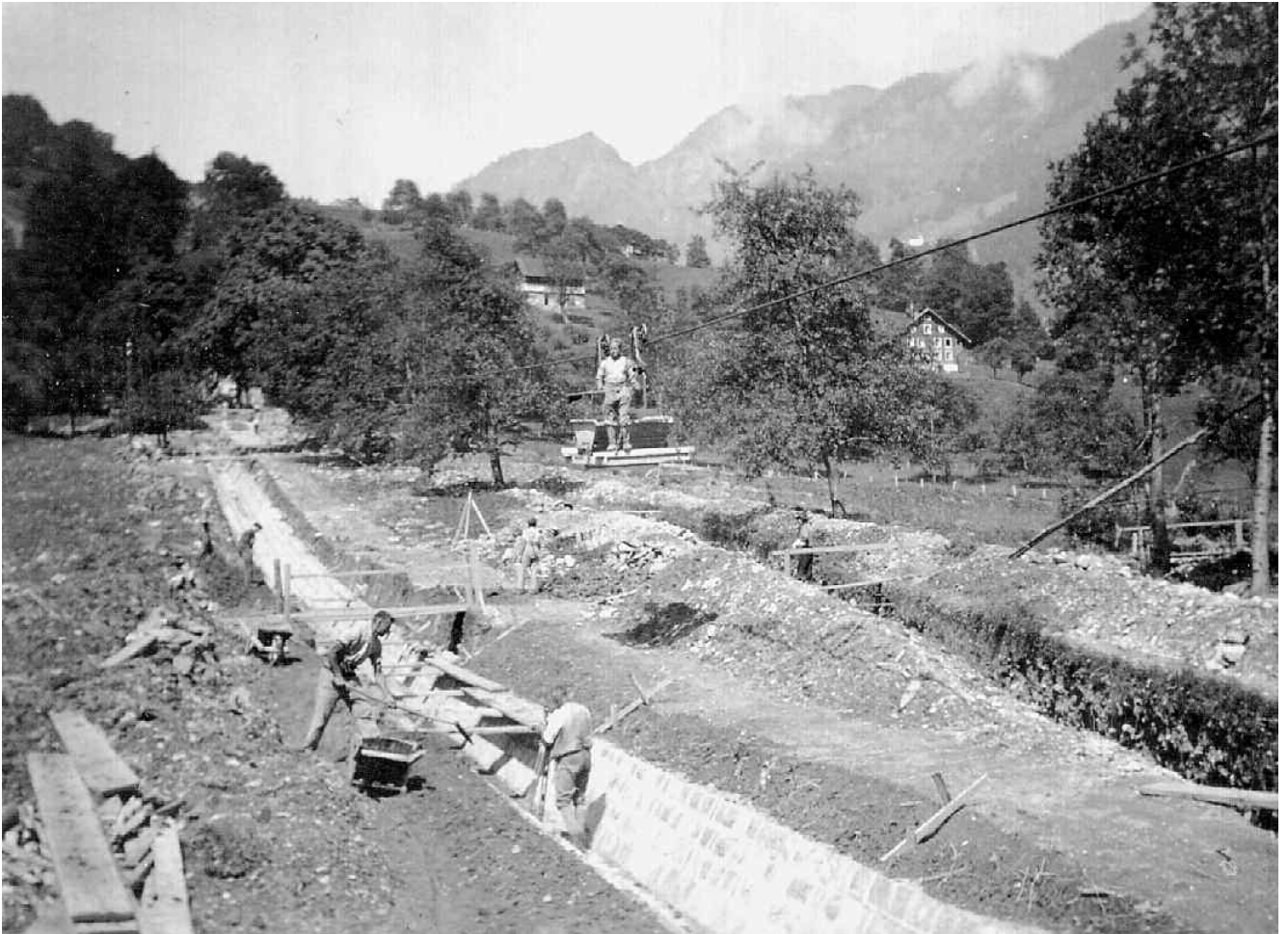
Bauarbeiten am Krättligbach-Kanal (1936)
