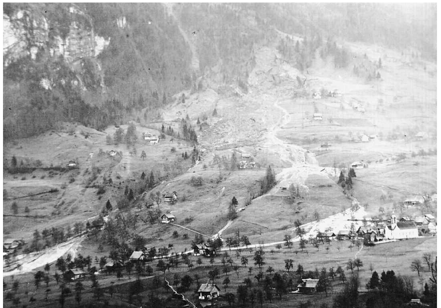
Übersicht über das Rutschgebiet (1936) (Anrissstelle, Rutschungen und Schlammströme bis zur Engelbergeraa)
