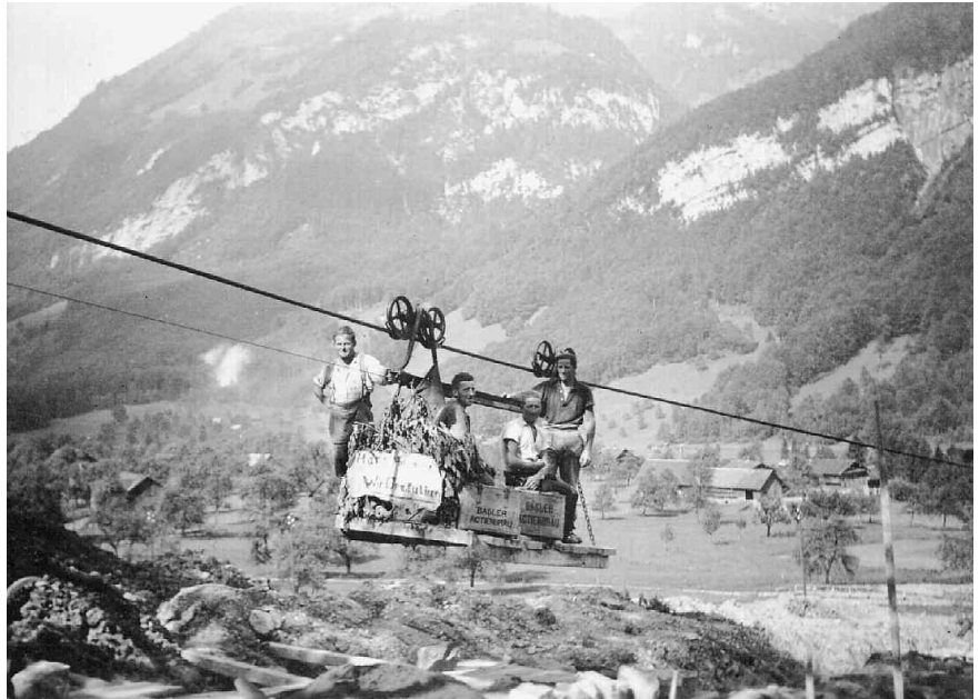
Transportseilbahn für den Bau des Lättenkanals (1936)
