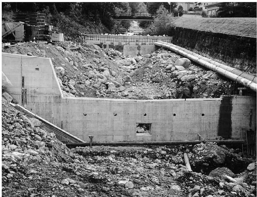
Verbauung Steinibach unterhalb der Kirchenbrücke
