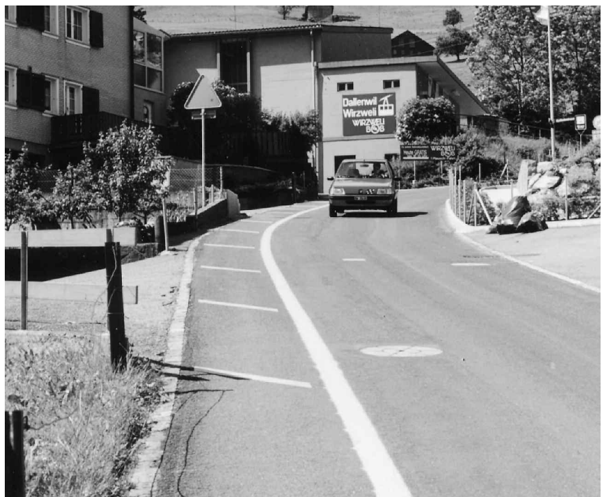
Die Fahrspur wird sichtbar eingeschränkt. Die Sicherheit der Fussgänger steigt.
