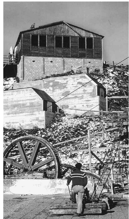
Notkirche Dallenwil als Stanserhornrestaurant vor dem Transport nach Dallenwil
