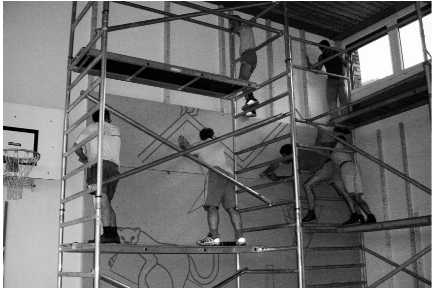
Knochenarbeit bei der Montage: Eine 5x1 m grosse Platte wird eingepasst und festgeschraubt.
