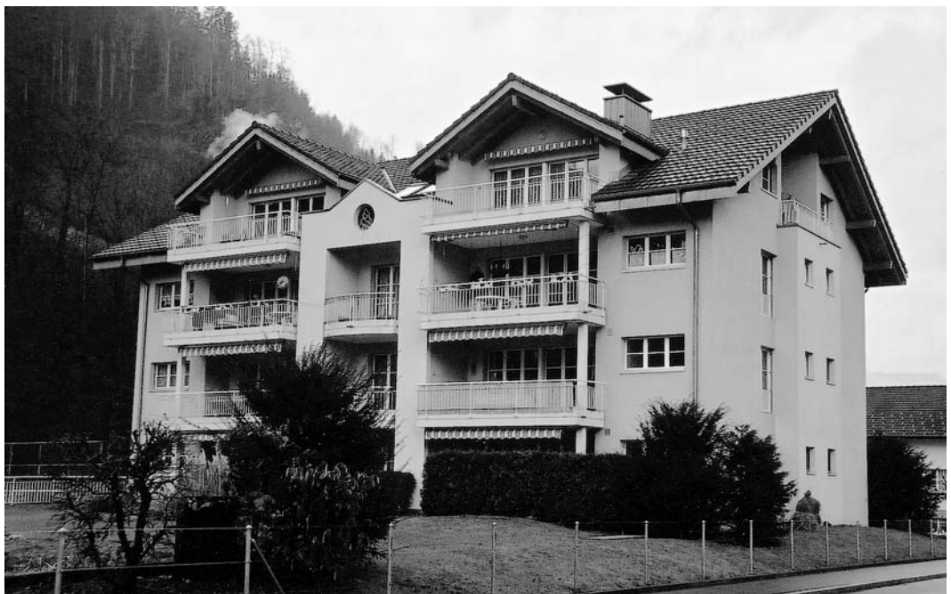
Wohnhaus Brandbodenstrasse 1, heute
