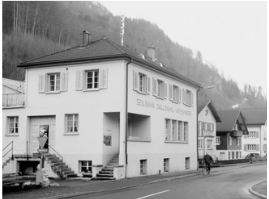
Kombinierte Sirenenanlage Bevölkerungsschutz und Wasseralarm auf dem Haus Talstation Wiesenbergbahn
