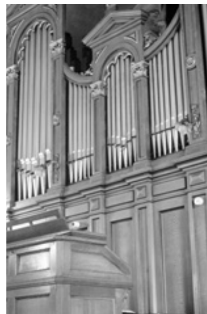
Die Goll-Organ 1903 – 1977, mit freistehendem Spieltisch, 14 Registern und pneumatischer Traktur
