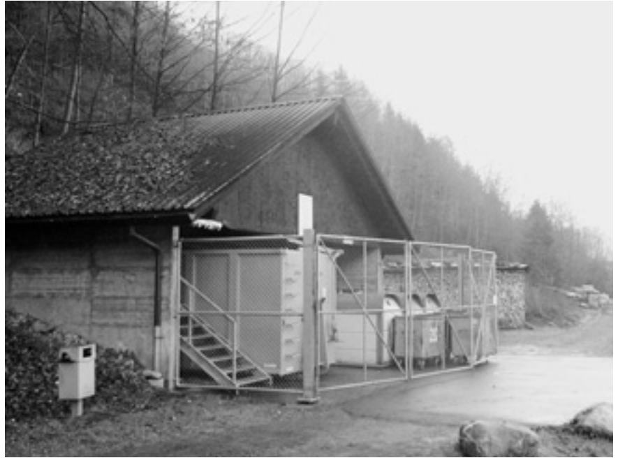
Altmaterial Sammelstelle Brandboden mit neuem Gitter
