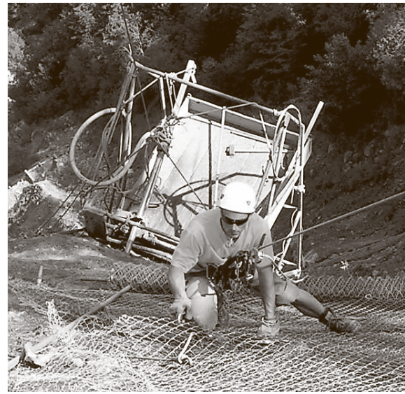
Steile Ribenen werden mit Netzen gesichert
