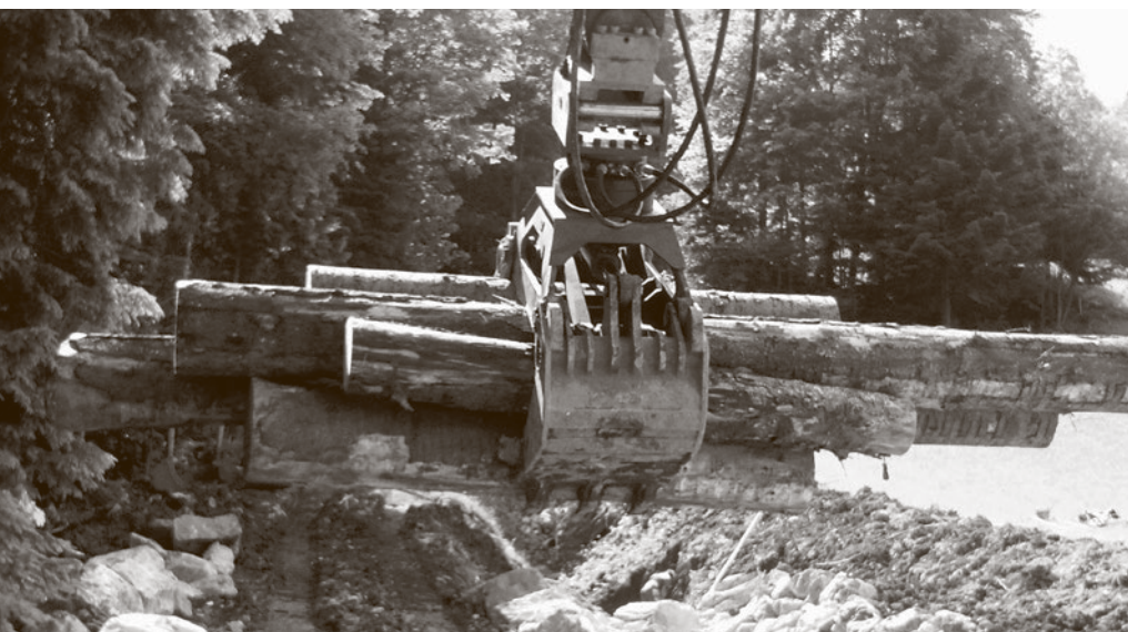
Krätlig: Bachverbauung mit viel Holz
