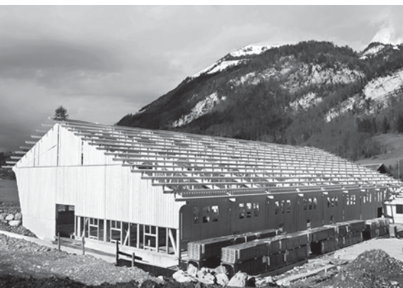
Neubau Stall, Strasshostet, Dallenwil
