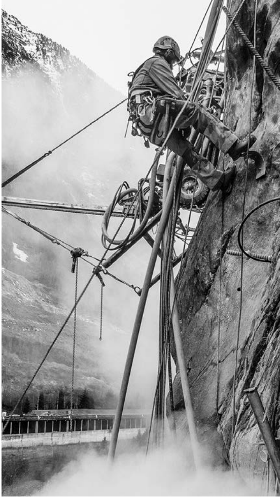
Seilarbeiten in luftiger Höhe
