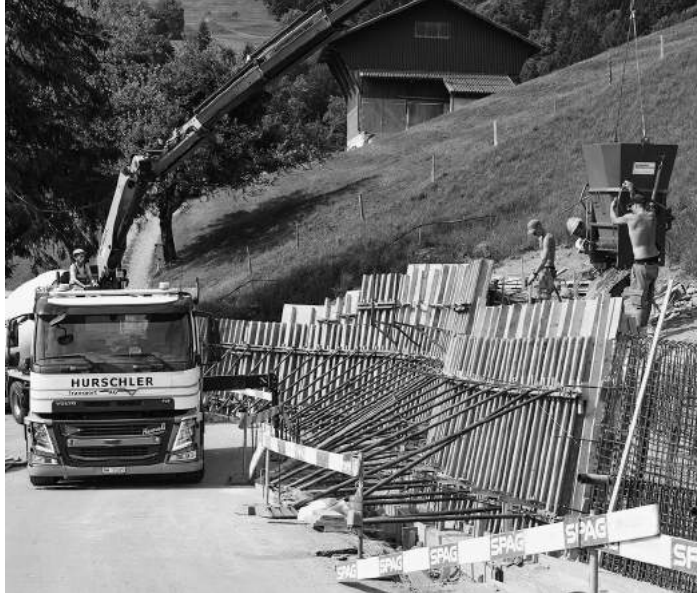
Die Mauer oberhalb der Einfahrt Ribistalden wird betoniert
