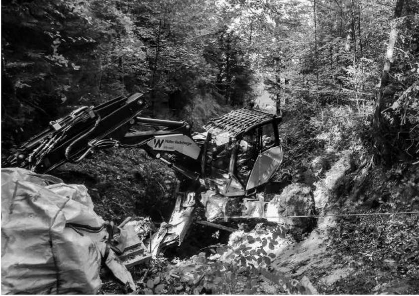
Im steilen Gelände werden die Entwässerungskännel ersetzt
