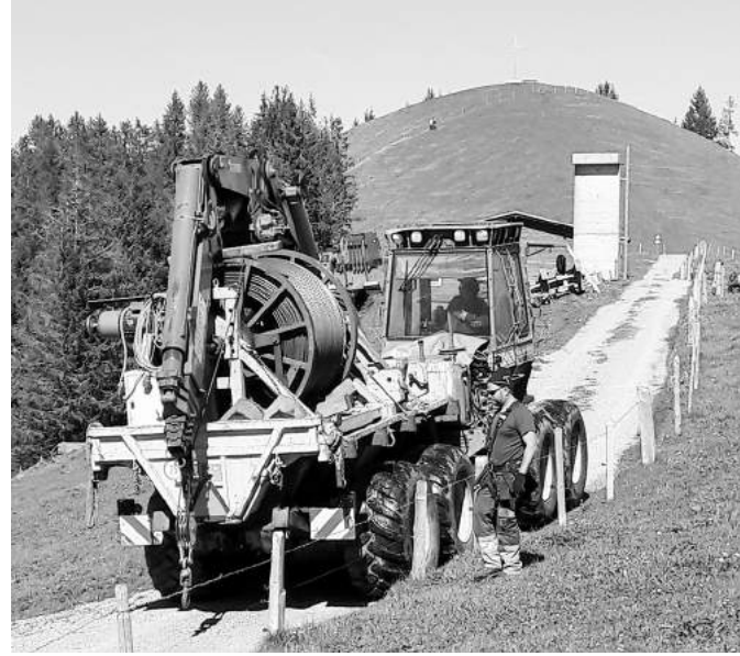
Rückbau des Skilifts Gummen
