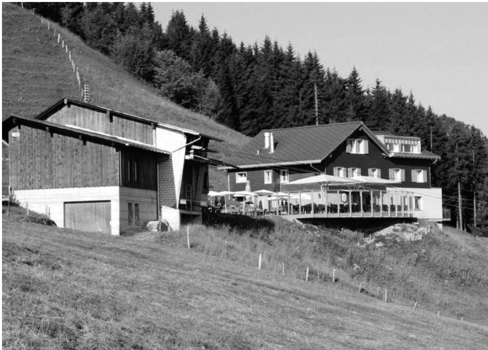
Heutiges Wohnhaus mit Restaurant, daneben die heutige Bergstation der Gummenseilbahn.
