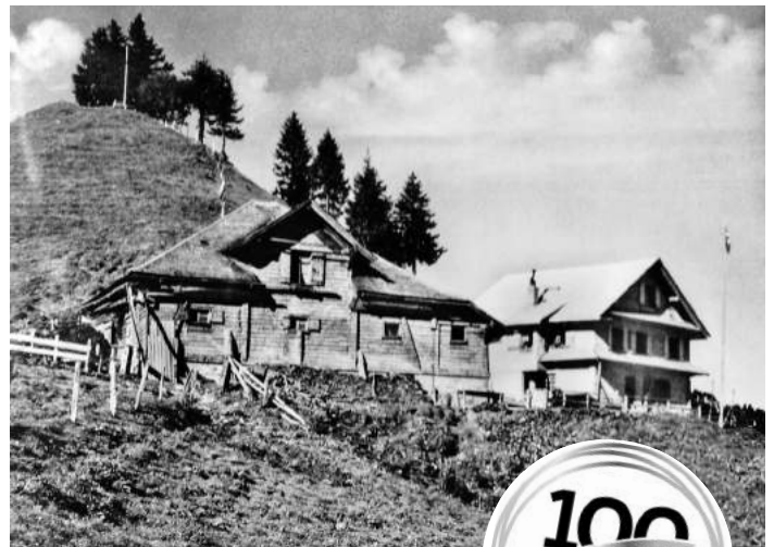
Alte Gummenhütte mit Stall
