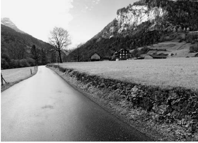
Trockensteinmauer entlang der Oberaustasse von Dallenwil nach Wolfenschiessen
