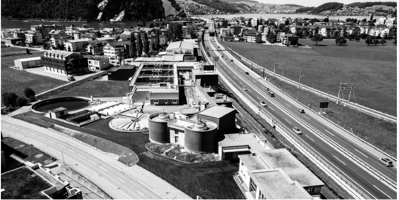
Bei den drei Abwasserverbänden in Nidwalden könnten viele Synergien genutzt werden. Bild ARA Rotzwinkel
