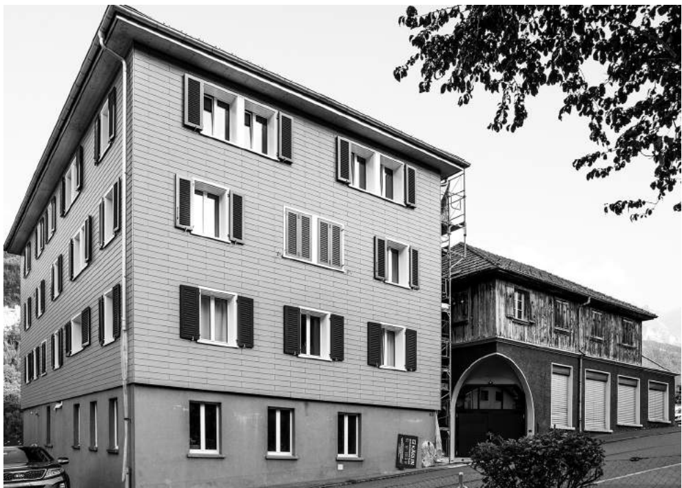
Das Haus an der Wiesenbergstrasse 5a/5b wurde im Jahr 2023 umgebaut
