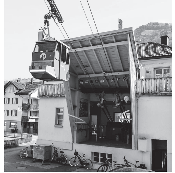
Wiesenberg-Bahn nimmt wieder Fahrt auf
