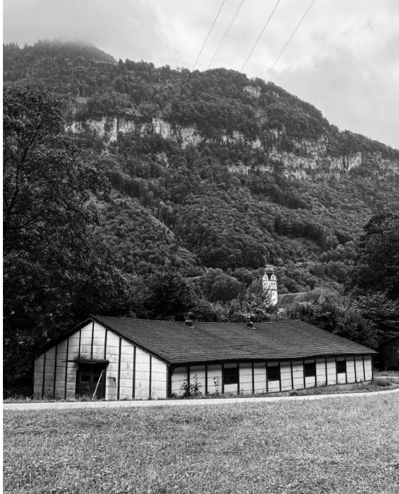
Militärbaracke Oberau kurz vor dem Abbruch
